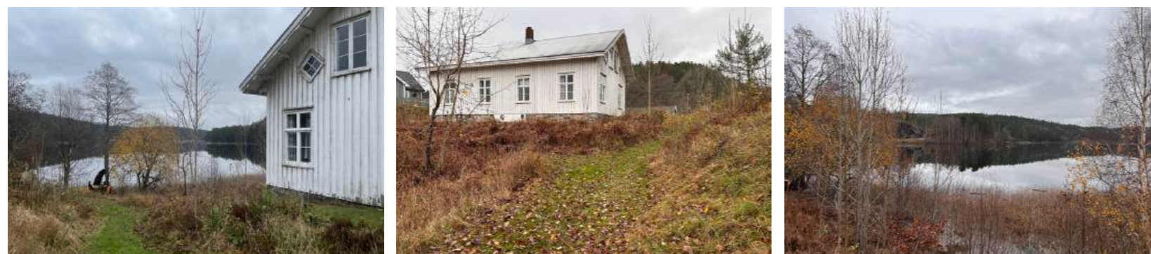
Bildene viser grendehuset med kobling mot vannet
